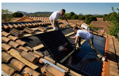
Pose de panneaux solaires intégrés à la toiture à Eyguières.
